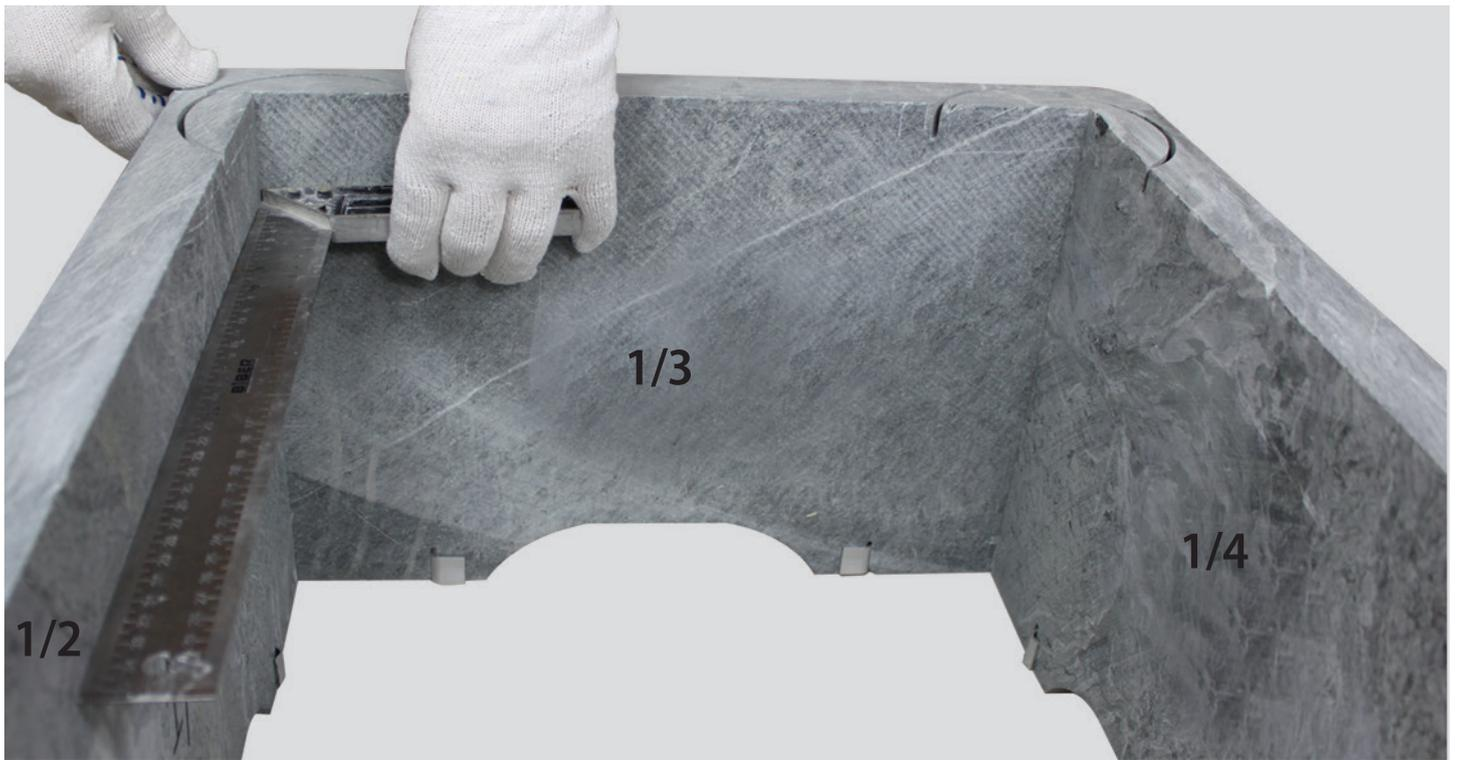
Приступаем к сборке второго ряда, который устанавливается по аналогичному принципу сборки первого ряда, устанавливаем детали 2/1, 2/2, 2/3 и так далее. Закладываем соответствующие скобы.
