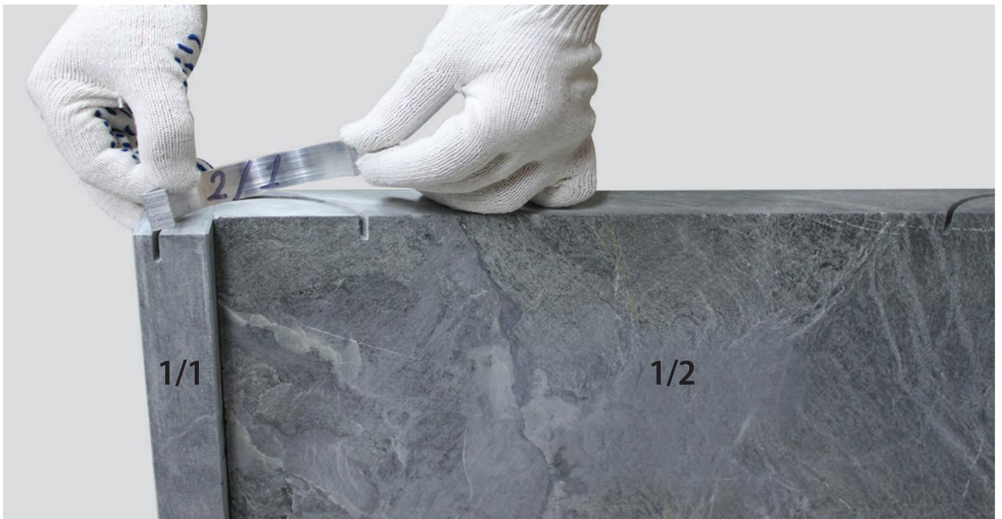
По мере установки деталей закрепляем их сверху скобами.
